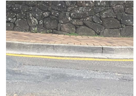
Concrete kerb edge
